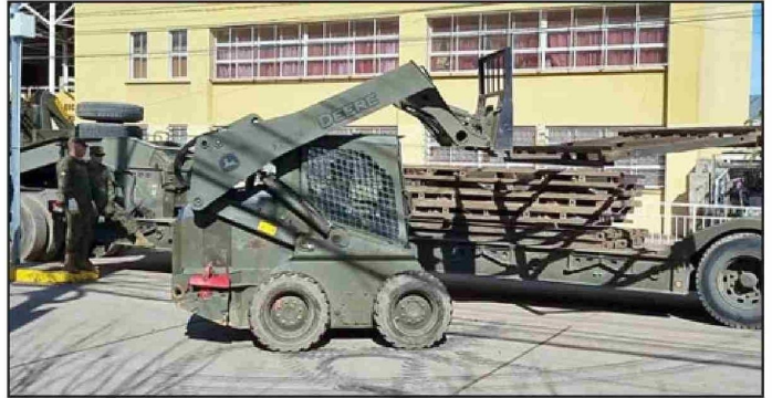
Ya se encuentra habilitado el puente mecano en Llay Llay.
