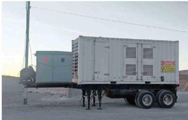
AYER POR LA MAÑANA SE LOGRÓ INSTALAR EL GENERADOR ELÉCTRICO A LA ESPERA DE LA REPOSICIÓN TOTAL.
