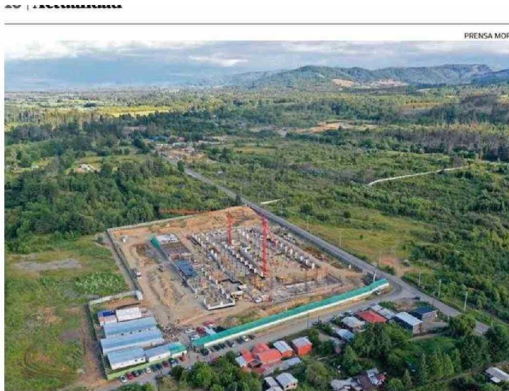
UNA SUPERFICIE ESTIMADA DE 12 MIL METROS CUADRADOS TENDRÁ EL NUEVO HOSPITAL DE LOS LAGOS.
