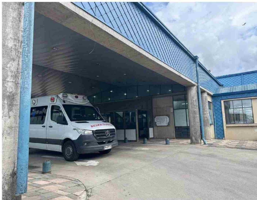
UNA MAYOR INFRAESTRUCTURA REQUIERE EL HOSPITAL DE CASTRO PARA TERMINAR CON EL COLAPSO DENUNCIADO POR DIRIGENTE.
