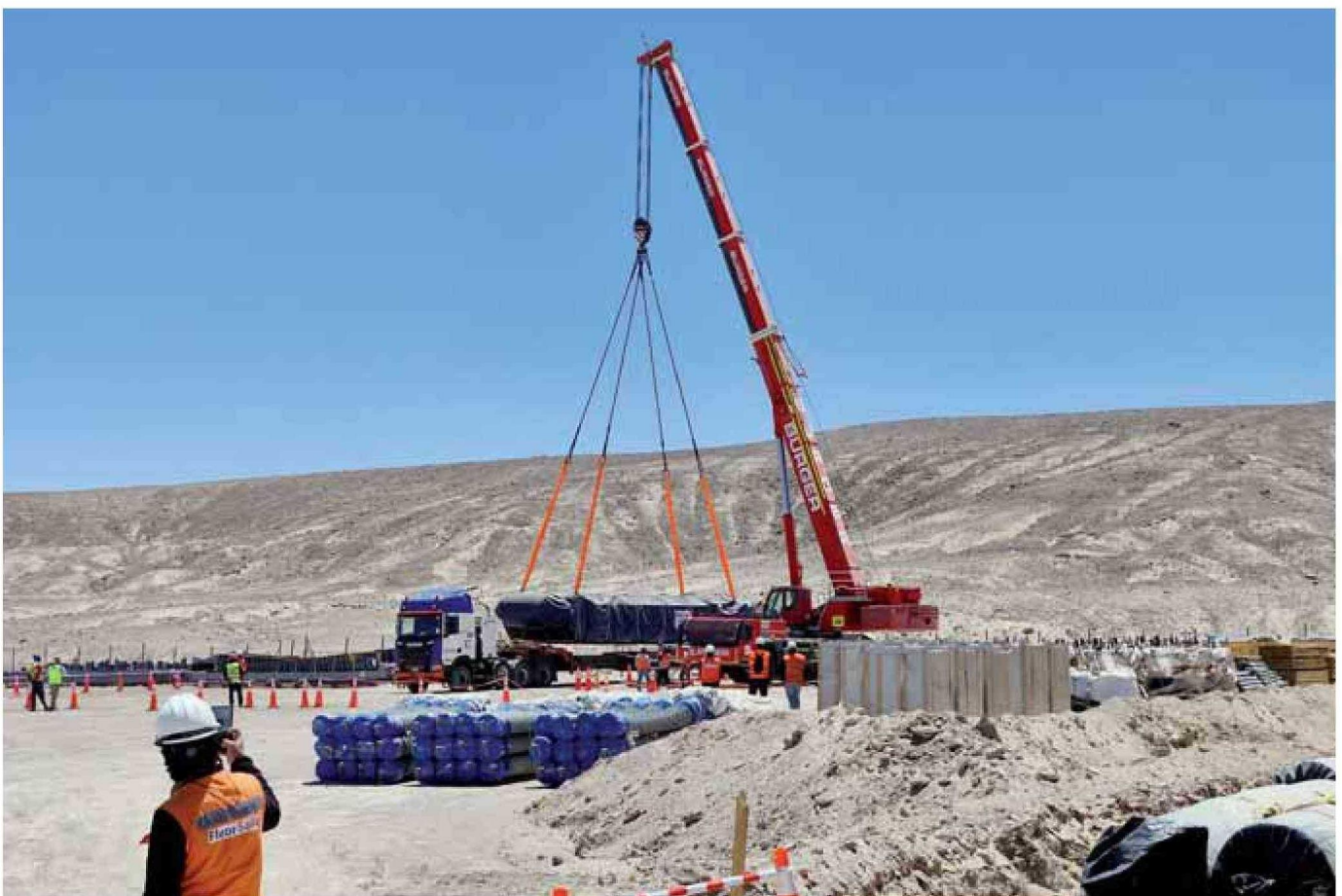
❖ Llegada de equipos críticos a faena.
