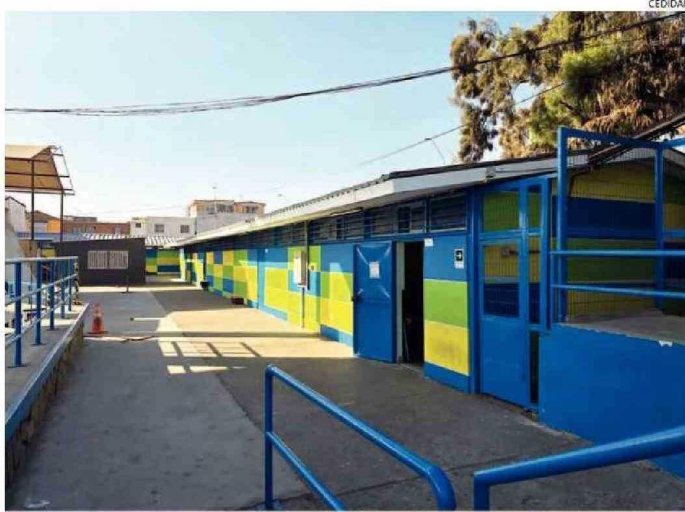
LAS OBRAS EN LA ESCUELA LAS ROCAS FINALIZARON.
