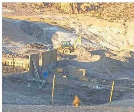
EN EL LUGAR HAY TRABAJOS DE MEJORAMIENTO DE PISCINA TERMAL.
