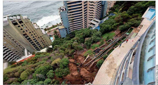
PELIGRO. — Los residentes aguas abajo del socavón se suman a las exigencias del Euromarina 2 para que Serviu aplique efectivas medidas de mitigación ante frente del mal tiempo.
