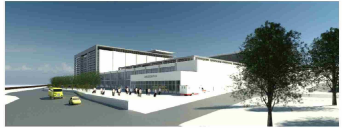
El nuevo hospital de Illapel es considerado como una obra de gran relevancia para la comuna.
