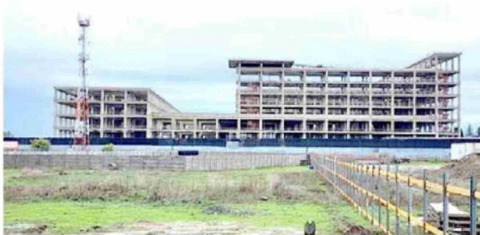
El anhelado nuevo centro asistencial se levanta en el sector poniente de Linares. Posee una superficie superior a 90 mil m 2 .
