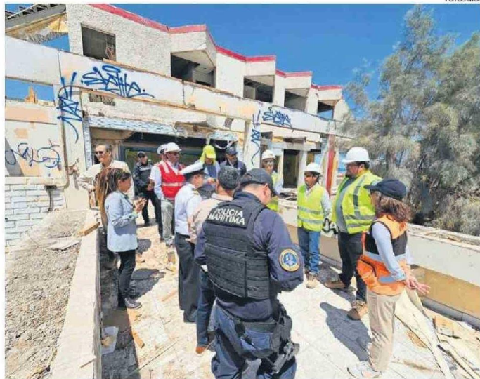
AHORA LA EMPRESA SE HARÁ CARGO DE LA DEMOLICIÓN.
