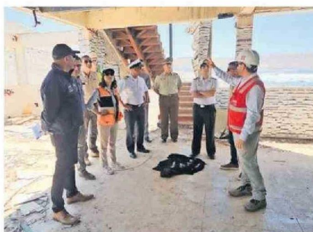
EN EL INTERIOR DEL INMUEBLE.
