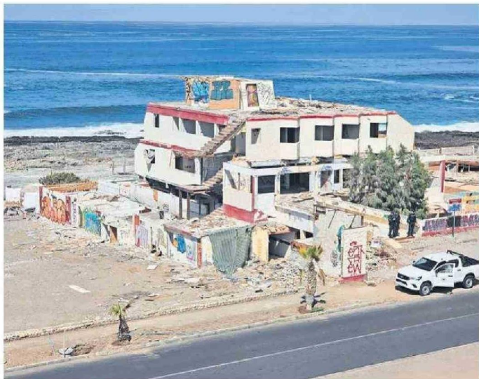
EN ESTAS CONDICIONES ESTÁ EL RECINTO EN EL SECTOR DE ARENILLAS NEGRAS.
