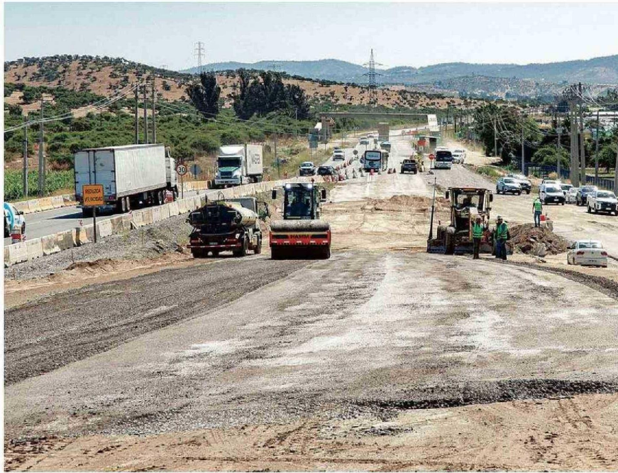
LAS OBRAS DE LA VARIANTE SAN JUAN PARTIERON EN MARZO DE ESTE AÑO.
