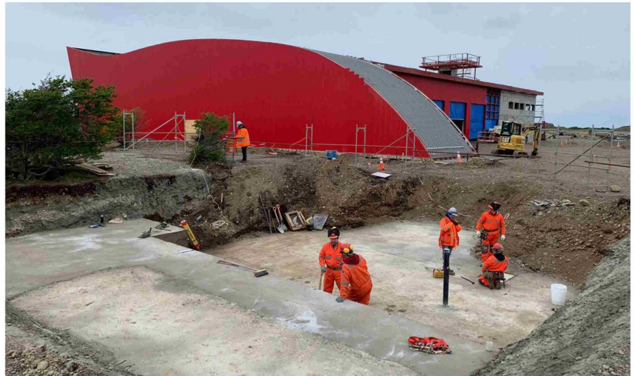
OBRAS QUE ACTUALMENTE SE ESTÁN EJECUTANDO EN LA REGIÓN DE MAGALLANES.
