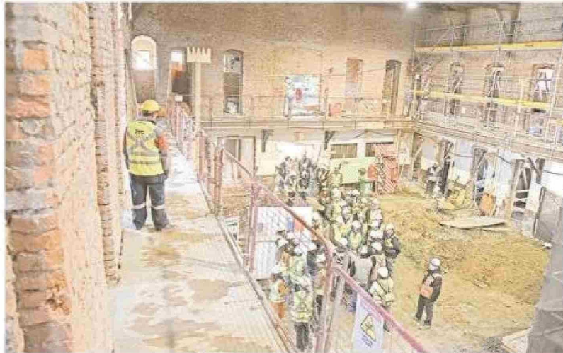
Una visita inspectiva a las obras que se ejecutan en la excárcel realizaron autoridades.
