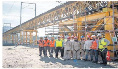
Las obras concluyeron a casi cuatro meses de detectada la anomalía.
