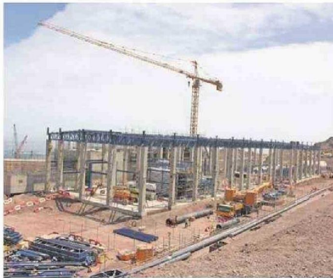
LA INICIATIVA LLEVA MÁS DE UN 40% DE AVANCE EN SUS OBRAS.
