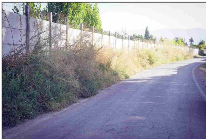
Esta semana se retoman trabajos de bacheo en San Rafael.
