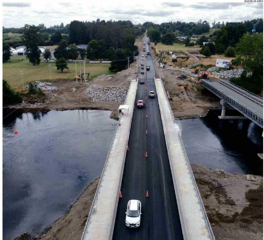
LA APERTURA AL TRÁNSITO DEL NUEVO PUENTE CANCURA SE REALIZÓ AYER, CON RESTRICCIÓN DE VELOCIDAD, YA QUE SIGUEN OBRAS MENORES.
