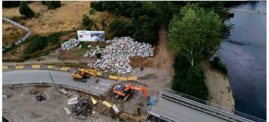
EL DESARME DEL PUENTE MECANO COMENZARÁ EL LUNES Y YA SE ESTÁN REALIZANDO LOS AJUSTES PREVIOS PARA CONCRETARLO.
