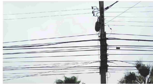
Tanto La Serena como Coquimbo se han convertido en nuevos focos de robos de cable en la región. CEBIDA
