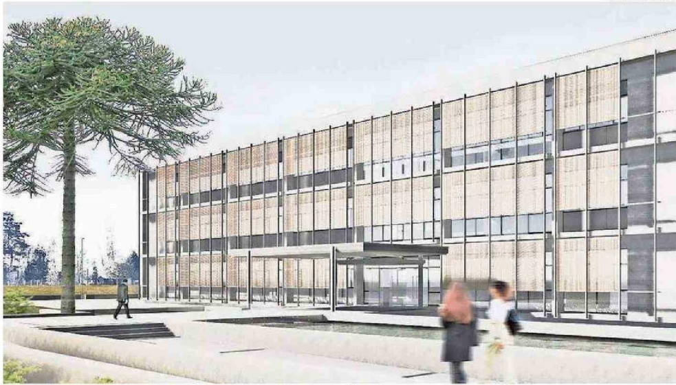
AMBAS ESTRUCTURAS REPRESENTAN UN IMPORTANTE HITO EN LA GENERACIÓN DEL POLO DE SALUD DE LA REGIÓN.
