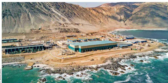
Planta desalinizadora de Minera Escondida, Región de Antofagasta.
