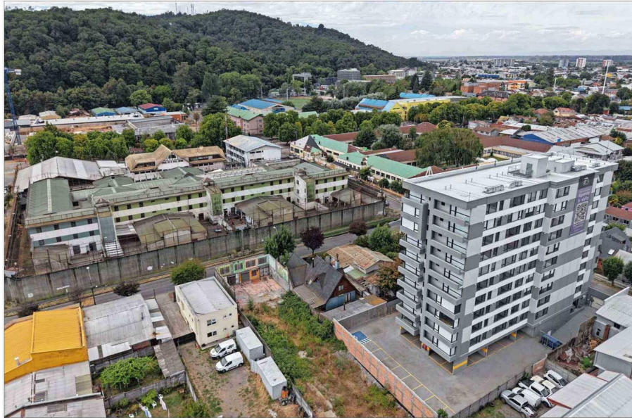
RIESGOSA UBICACIÓN. — Once pisos tiene el edificio Almirante (abajo, a la derecha), cuya entrada se ubica por calle Lynch 146. Las ventanas con orientación hacia Miraflores tienen vista directa a los módulos y patios traseros del penal, cuyo ingreso está por avenida Balmaceda.
