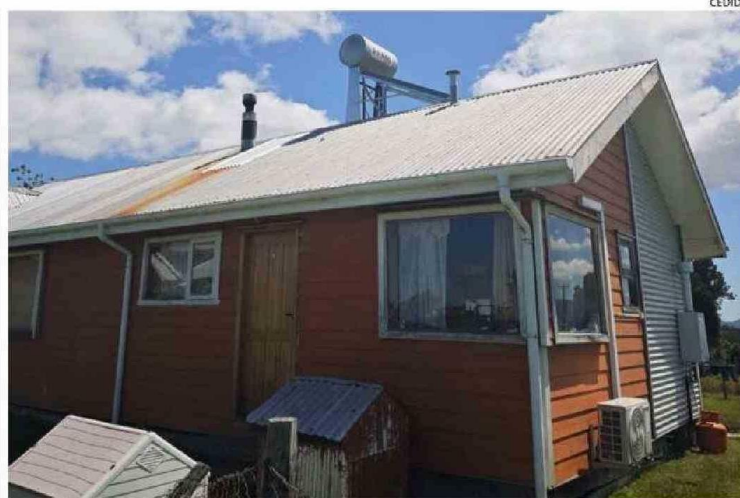
INSTALACIÓN EN UNA DE LAS CASAS DE LAS 25 FAMILIAS FAVORECIDAS EN CHONCHI.
