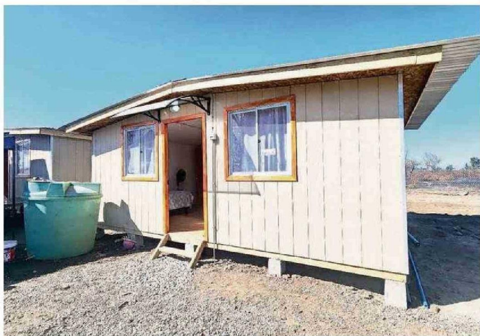
LA VIVIENDA DE EMERGENCIA PERMITE ENFRENTAR CON RAPIDEZ EL DAÑO GENERADO POR EL FUEGO.
