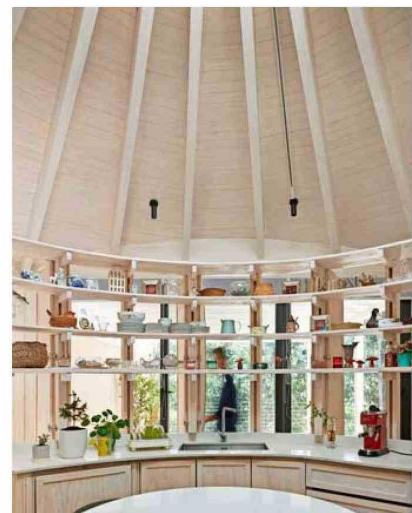
Casa en Nonguén. Estructura de madera laminada Lamitec y revestimientos y puertas de pino finger.
