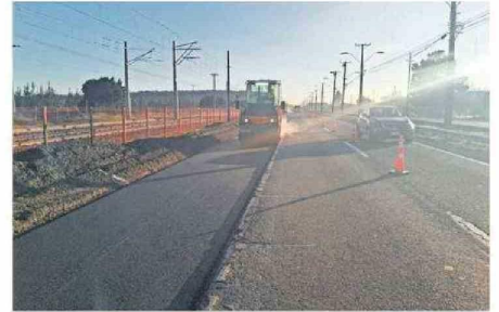
Los trabajos alcanzan un 3% de avance.
