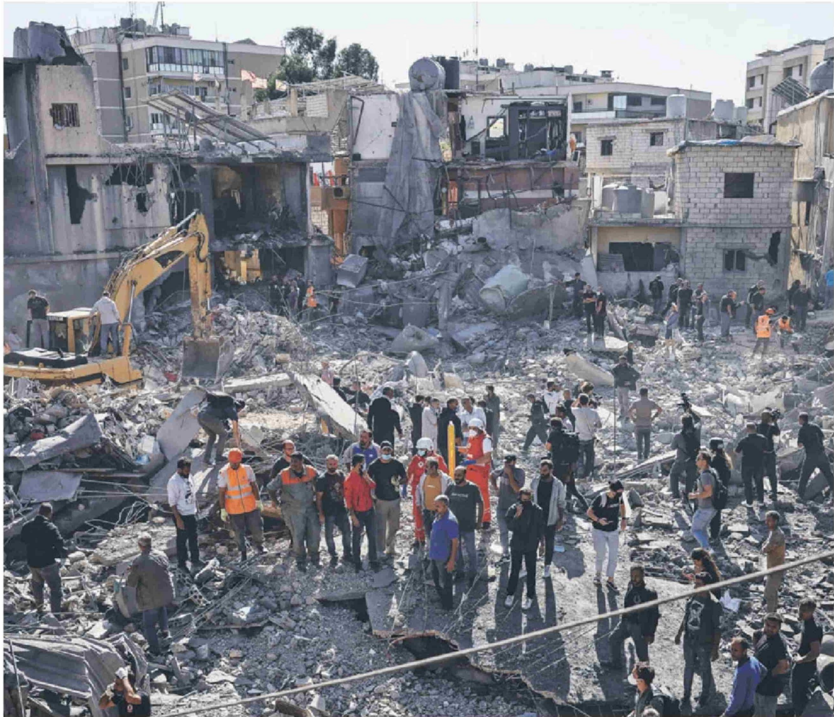
► Vista de un edificio demolido tras un ataque israelí cerca del Hospital Universitario Rafik Hariri, en Beirut, el martes pasado.
