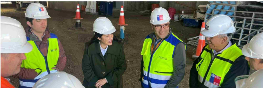
AUTORIDADES VISITARON LAS OBRAS QUE SE ESTÁN REALIZANDO EN LA REGIÓN DE MAGALLANES Y ANTÁRTICA CHILENA.
