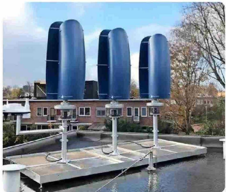
Estas miniturbinas de eje vertical se ajustan fácilmente a la infraestructura que ya existe.
