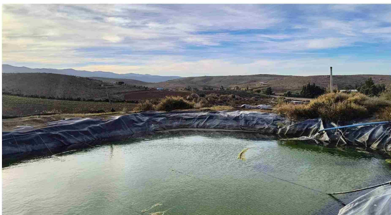
Las obras hídricas son vitales para conversar el agua, en este caso, destinada a la actividad agrícola.
