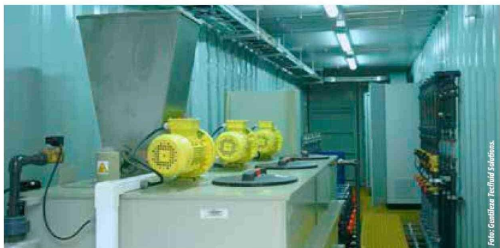
Planta Automática de Dosificación de Reactivos.
