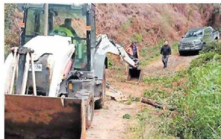
En el Parque Nacional Nonguén se realizaron trabajos de despeje.
