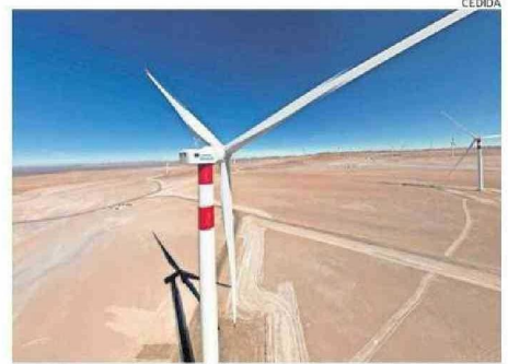
24 DE LOS 57 AEROGENERADORES YA FUERON INSTALADOS POR ENGIE.
