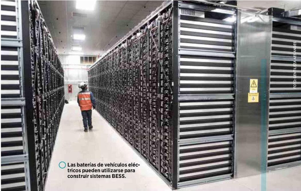
Las baterías de vehículos eléctricos pueden utilizarse para construir sistemas BESS.
