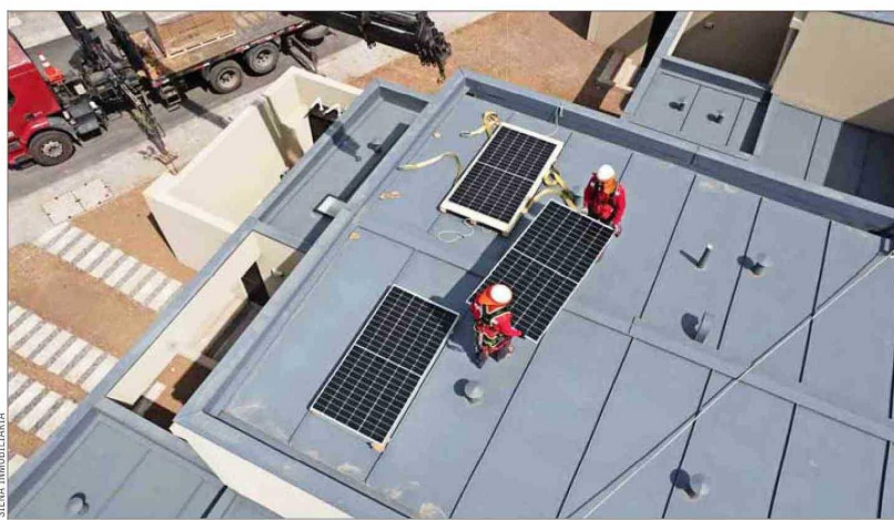
Las casas del Condominio Canquén Norte tienen instalados los paneles en la cubierta del techo.
