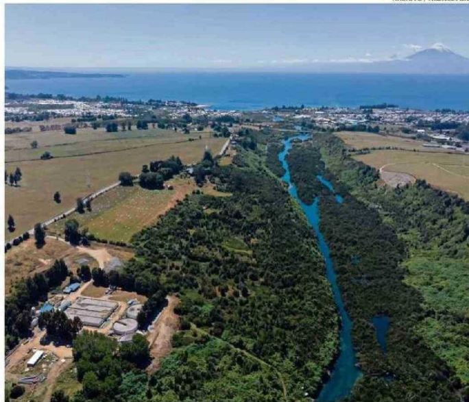
LA PLANTA DE TRATAMIENTO ESTÁ JUNTO AL RÍO MAULLÍN, A UNOS 2 KILÓMETROS DEL CENTRO DE LLANQUIHUE.
