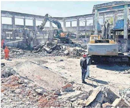
DE 8.00 A 18.00 HORAS DE TRABAJA EN LA DEMOLICIÓN.
