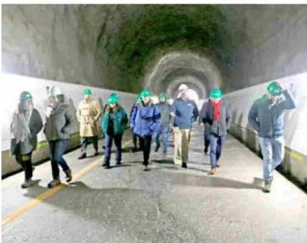
Un prolongado túnel antecede a la sorprendente caverna de máquinas donde se ubica el corazón de la generación de energía que abastece a más de un millón de habitantes.
