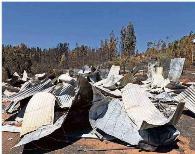
CINCO CASAS Y TRES GALPONES RESULTARON DESTRUIDOS POR EL INCENDIO QUE PARTIÓ EN COIPUCO.
