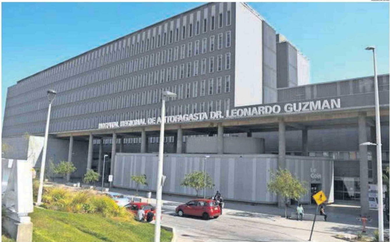
EL HOSPITAL REGIONAL DE ANTOFAGASTA HA SUFRIDO VARIOS INCIDENTES EN RELACIÓN A FILTRACIÓN DE AGUA POR EL SISTEMA DE CLIMATIZACIÓN.
