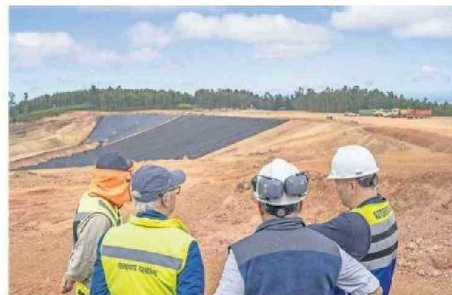
Durante el 2024 realizaron 59 inspecciones.
