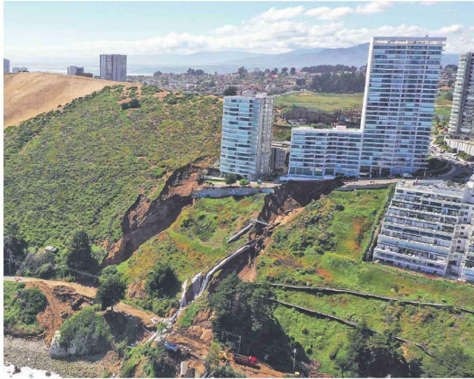
Crece el peligro para habitantes de los costosos edificios de las dunas de Concón. /MOP
