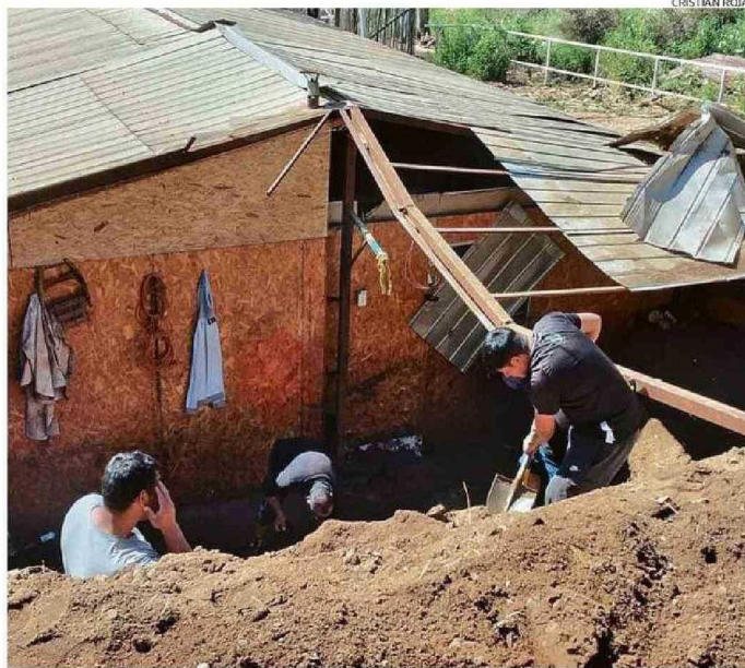
FAMILIARES Y AMIGOS DE PATRICIA PIZARRO LA AYUDAN EN EL RETIRO DE BARRO Y ESCOMBROS.
