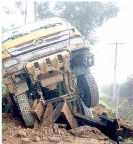
El vehículo pesado cruzó la estructura de madera, con un sobrepeso de tres veces lo permitido.
