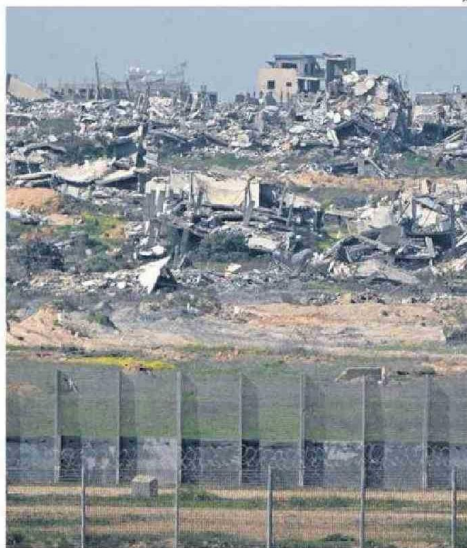
EDIFICIOS DESTRUIDOS EN LA FRANJA DE GAZA VISTOS DESDE EL SUR DE ISRAEL.
