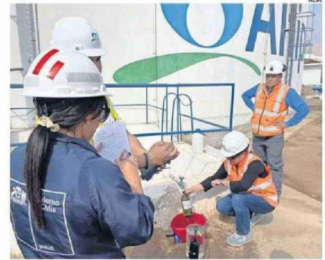
SE ESTÁ A LA ESPERA QUE LA AUTORIDAD SANITARIA CONFIRME LA SOLUCIÓN DEL PROBLEMA.
