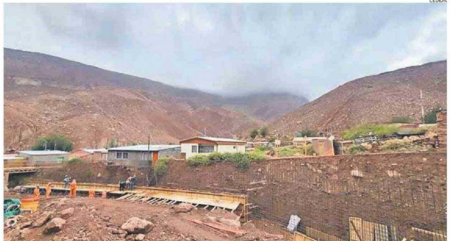
LOS TRABAJOS DE MITIGACIÓN QUE REALIZA EL MOP EN LA LOCALIDAD DE RÍO GRANDE, COMUNA DE SAN PEDRO DE ATACAMA TRAS LAS LLUVIAS.
