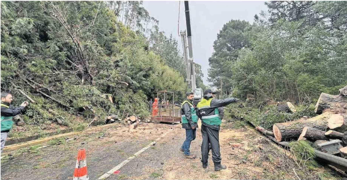
En Talcahuano continúan con los equipos trabajando en el despeje de vías tras la caída de árboles.
