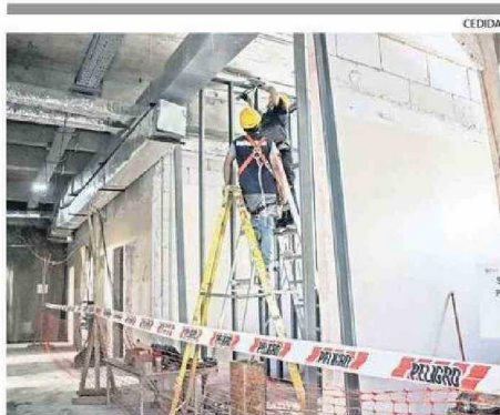
CONSTRUCCIÓN DE PABELLONES EN EL HOSPITAL HIGUERAS.
