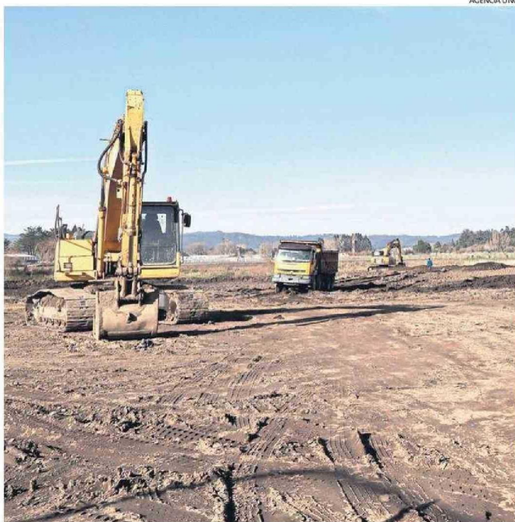
ESTE ES EL TERRENO QUE ESTÁ SIENDO INTERVENIDO EN EL SECTOR BRISAS DEL SOL.
